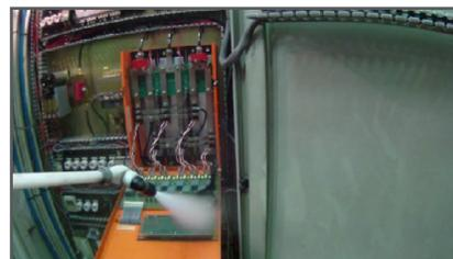
È un dato certo il fatto che il sistema di pulizia Elclean300ES aiuta a mantenere in un corretto stato di funzionamento sia i componenti che le apparecchiature all'interno dei Quadri Elettrici.
